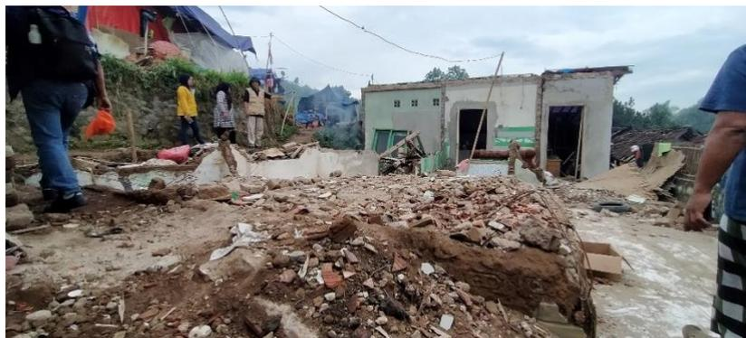
家屋は倒壊したが、台所と浴場・トイレは残った。瓦礫を移動し、ゴトンロヨンモデルのシェルターを建設し、浴場・トイレは共同MCKとして使用予定。
